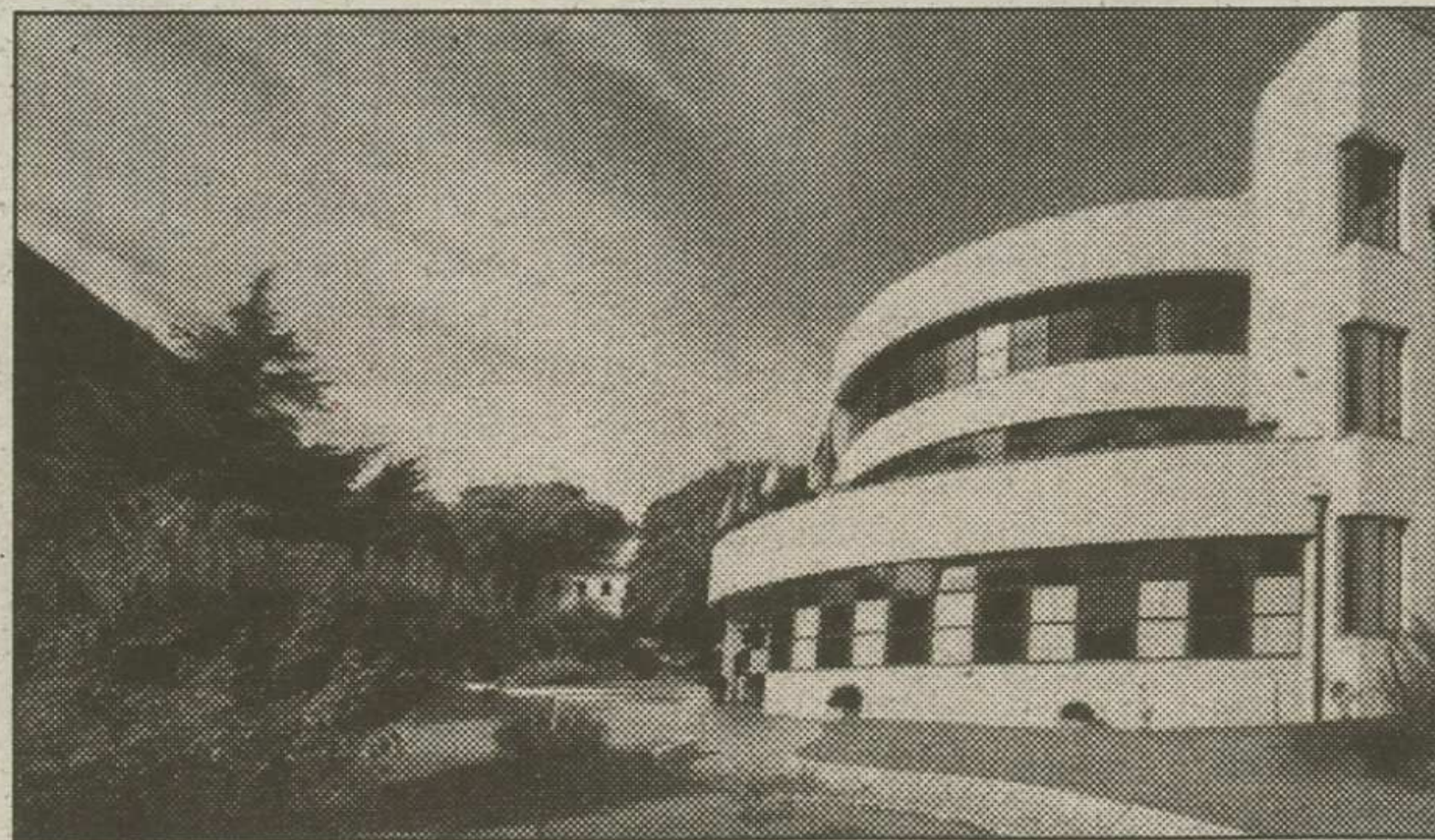
Lo stabilimento delle Terme Caronte
